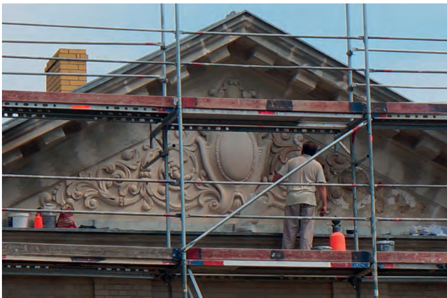
Pałac podczas remontu. Fot. Roma Wesołowska.
