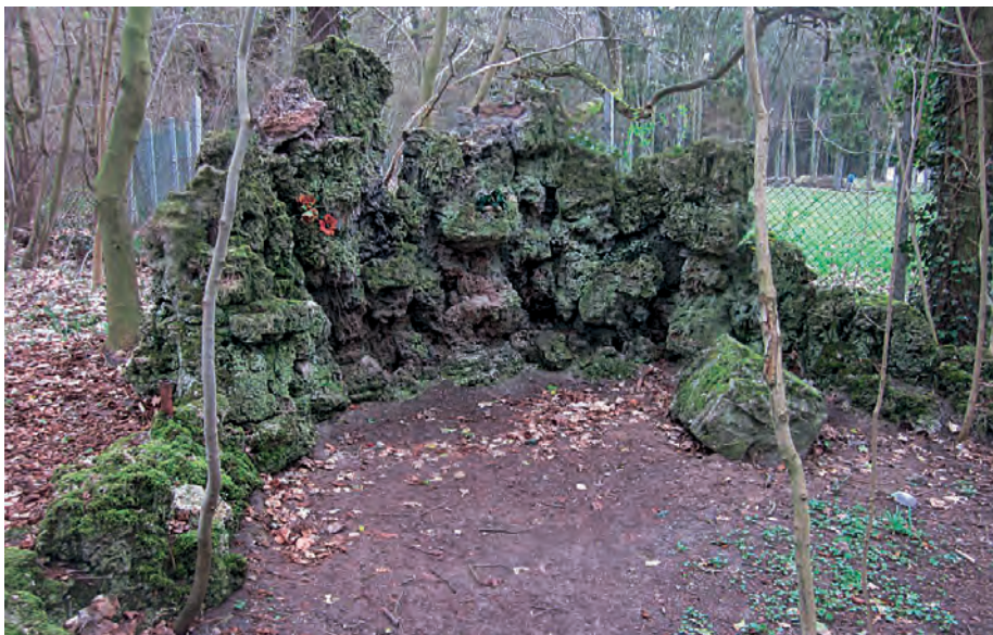
Rozpadająca się grota, element historycznego zagospodarowania, o którym niestety niewiele wiadomo, stan obecny (2017 r.). Fot. Małgorzata Haas-Nogal.
